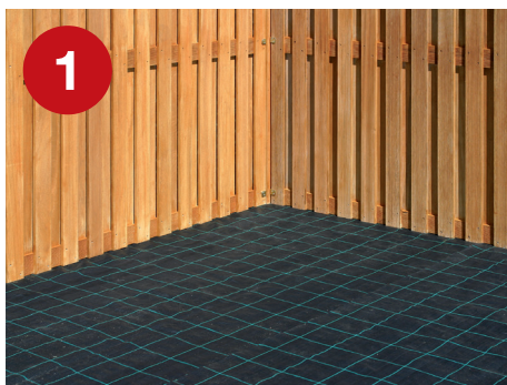
Stap 1 Verwijder eerst al het onkruid. Egaliseer de ondergrond en gebruik een anti worteldoek.
