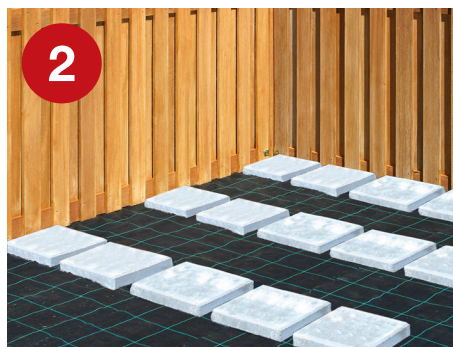
Stap 2 Plaats de (stoep)tegels op het anti worteldoek
